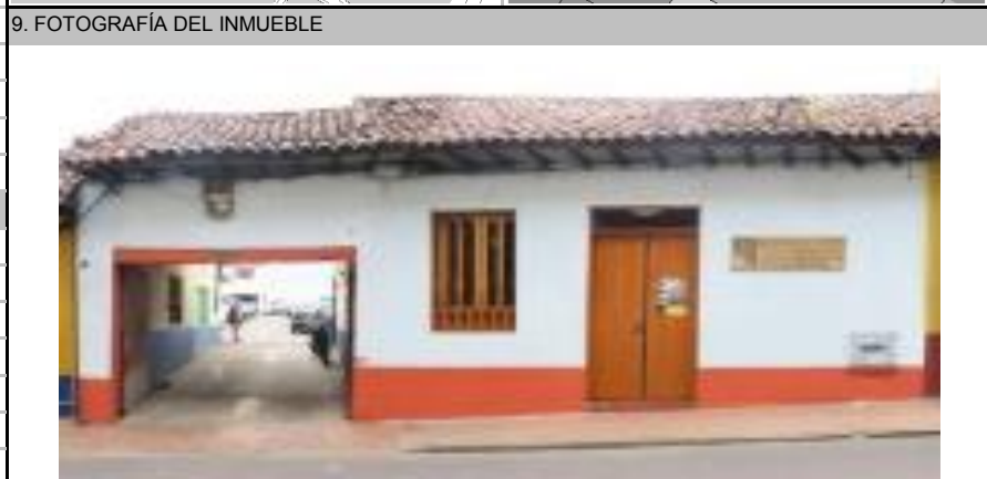
Fuente: Equipo Fotografía PEMP Patrimonio Inmueble
